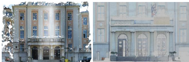
Фиг. 3 Заснемане на фрагмент от фасада „Север“ на СГСАГ „Христо Ботев“ в град София посредством наземна фотограмметрия и наземно лазерно сканиране
